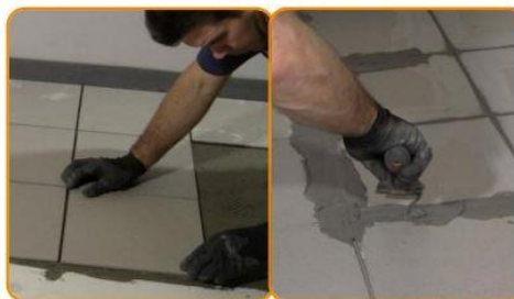
Posare la pavimentazione in ceramica o legno
